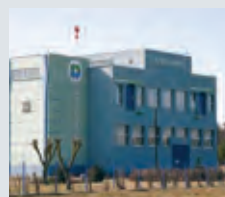
Miejskie Wodociągi i Oczyszczalnia, Grudziądz, Polska
